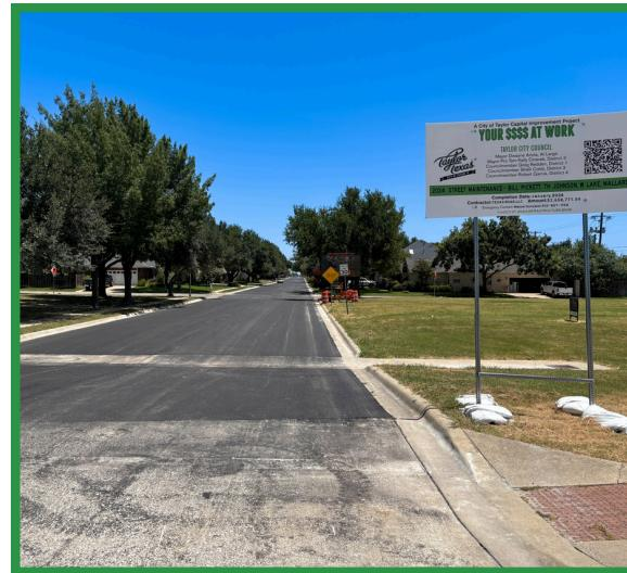
Toda la sección de la vía está siendo pavimentada de nuevo, y las mejoras de señalización incluyen una nueva línea central y hombros que pueden utilizarse para estacionamiento o bicicletas.
